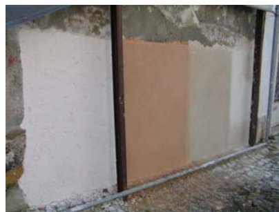
Fig. 20 - Vista geral dos 4 painéis finalizados
