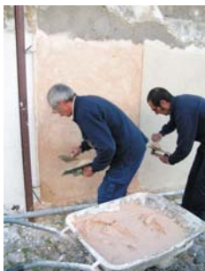
Fig. 5 - Continuação da aplicação da camada de argamassa
