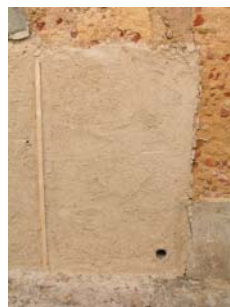
Fig.52 - Aspecto final do painel 1 – Argamassa tipo A, já regularizado
