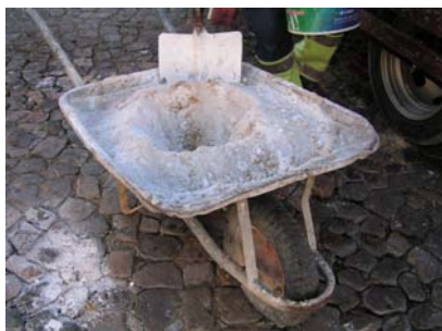
Fig. 27 - Buraco para adicionar água à mistura
