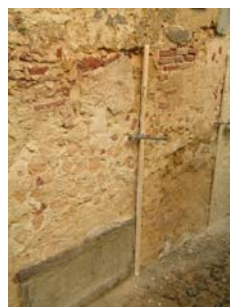
Fig. 48 - Aspecto geral do suporte em alvenaria antiga do edifício 2
