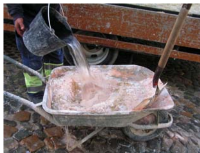
Fig. 26 - Junção de água à amassadura da argamassa
