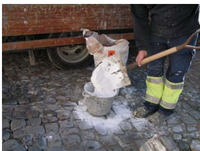
Fig. 45 - Início da execução da primeira camada de argamassa, de traço 1:1:6 – Edifício 2
