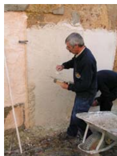
Fig. 34 - Início da aplicação da terceira e última camada da argamassa tipo B do painel 2
