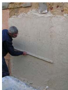
Fig. 41 - Regularização da camada de argamassa aplicada, com uma régua de madeira
