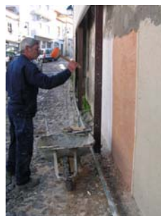
Fig. 20 - Continuação da molhagem da argamassa tipo C
