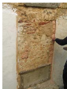
Fig. 56 - Início da aplicação da primeira camada da argamassa tipo C (colocação de régua como bitola)
