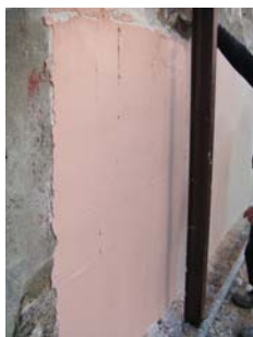
Fig. 13 - Camada aplicada na totalidade
