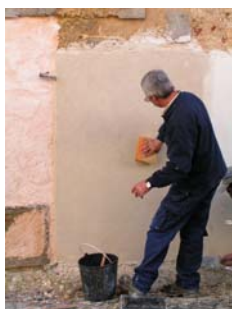
Fig. 41 - Passagem com esponja humedecida para alisar a camada de argamassa
