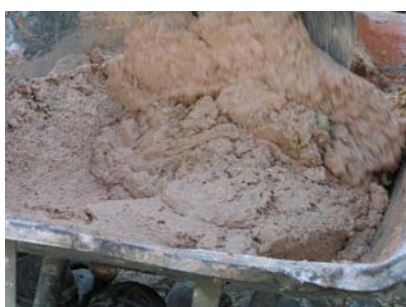
Fig. 3 - Continuação da amassadura manual da argamassa
