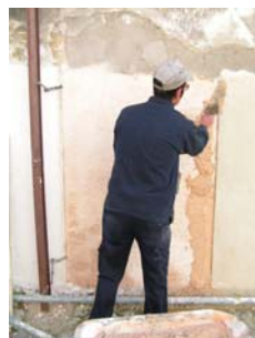
Fig. 51 - Início da aplicação da segunda camada do painel 3, de baixo para cima
