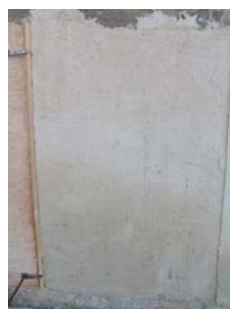
Fig. 8 - Aspecto final da segunda camada de argamassa do painel 2, cerca de 6 semanas após a sua aplicação
