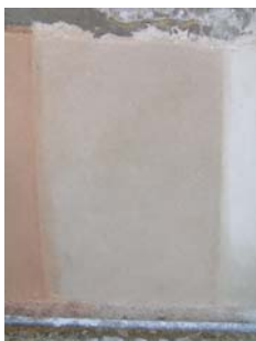
Fig. 17 - Aspecto final do painel 2
