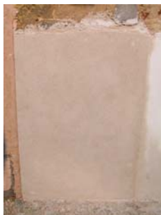
Fig. 64 - Aspecto final do painel 2 – Argamassa tipo B
