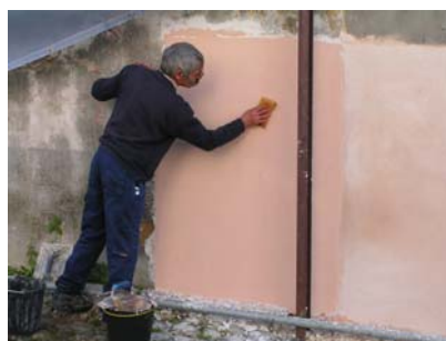
Fig. 16 - Passagem com uma esponja humedecida para regularização da superfície
