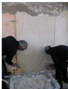
Fig. 11 - Início da aplicação da terceira camada de argamassa tipo B – Painel 2 (de baixo para cima)
