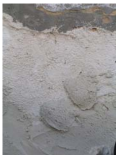
Fig. 11 - Pequenas porções projectadas contra o suporte
