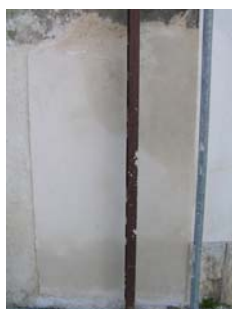
Fig. 7 - Aspecto final da terceira camada de argamassa do painel 1, cerca de 6 semanas após a sua aplicação
