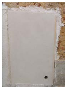
Fig. 38 - Aspecto do painel 1 finalizado – Argamassa tipo A (início da secagem)
