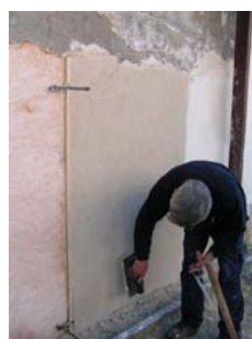
Fig. 18 - Continuação dos trabalhos, pressionando com a talocha com movimentos circulares
