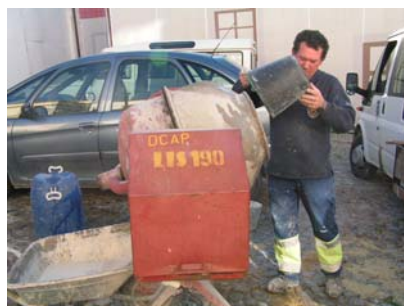
Fig. 46 - Início da execução da primeira camada de argamassa, de traço 1:1:6 – Edifício 2
