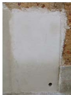
Fig. 30 - Aspecto final da terceira camada de argamassa do painel 1, cerca de 6 semanas após a sua aplicação
