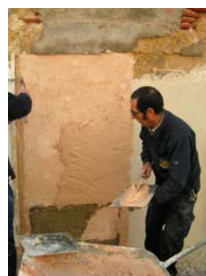
Fig. 32 - Continuação dos trabalhos
