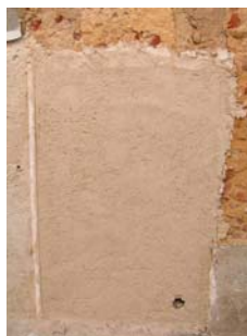
Fig. 64 - Aspecto final da argamassa tipo A (segunda camada de revestimento)
