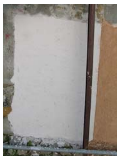
Fig. 60 - Aspecto final da primeira camada de argamassa do painel 4, cerca de 6 semanas após a sua aplicação
