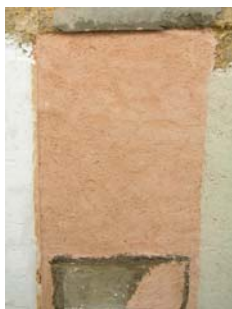
Fig. 43 - Aspecto final da argamassa tipo C – Painei 3, após 24 horas da sua aplicação
