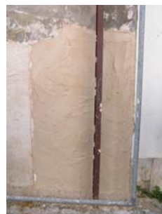
Fig. 47 - Regularização da camada de reboco, com uma ripa de madeira
