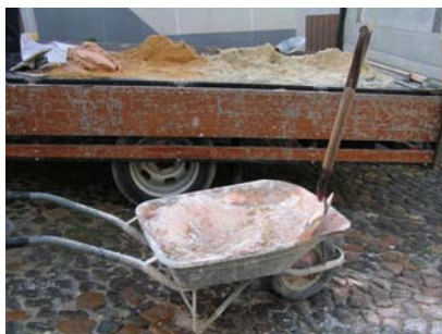
Fig. 25 - Início da execução da 3ª camada da argamassa de cal e metacaulino, de traço 1:0,5:3,5 – Painel 3
