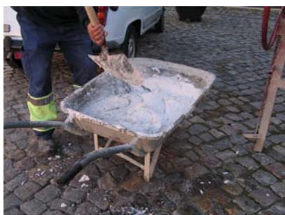
Fig. 13 - Início da execução da argamassa tipo D, pré-doseada, a aplicar no painel 4
