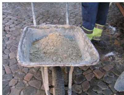
Fig. 22 - Junção de um balde e meio de areia grossa à mesma quantidade de areia fina
