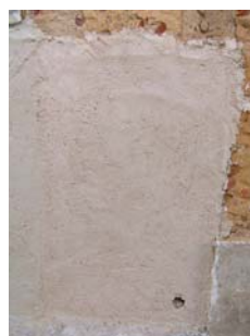
Fig.46 - Aspecto final da argamassa tipo A – Painei 1, após 15 dias da sua aplicação
