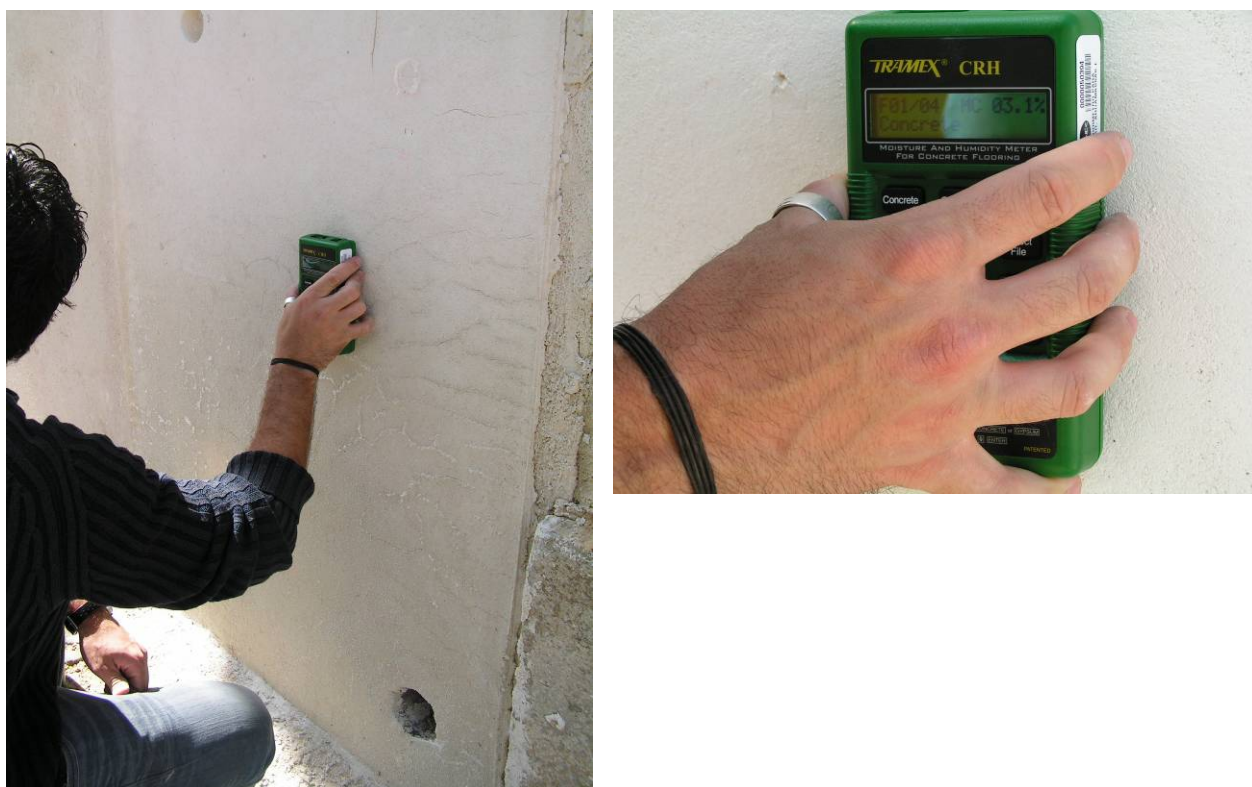
Fig. 11 – Ensaio com humidímetro: medições no painel 1 e pormenor
