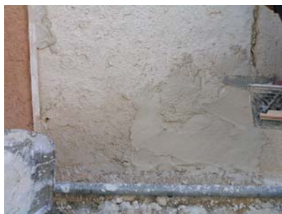
Fig. 10 - Aplicação de baixo para cima
