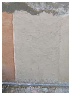
Fig. 12 - Aspecto final da segunda camada da argamassa tipo B
