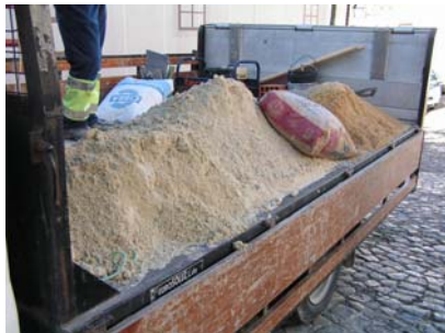
Fig. 3 - Materiais necessários para a execução das argamassas (cal, areia, cimento) e equipamento
