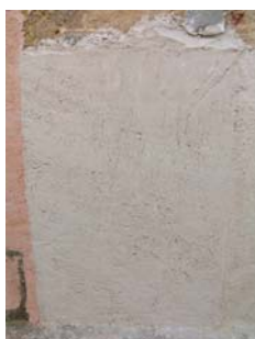
Fig. 45 - Aspecto final da argamassa tipo B – Painei 2, após 16 dias da sua aplicação
