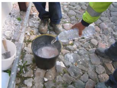
Fig. 5 - Junção de 1 litro de água (recomendado pelo técnico comercial da Weber)
