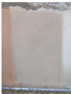
Fig. 17 - Aspecto final do painel 2
