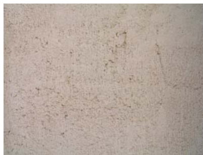
Fig. 28 - Pormenor da textura da argamassa tipo A
