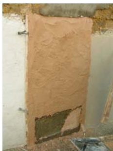
Fig. 33 - Aplicação da camada finalizada
