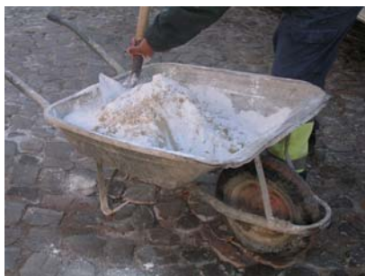
Fig. 3 - Amassadura manual
