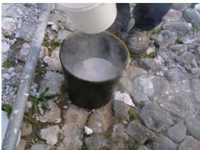
Fig. 3 - Acabamento final em pó, cor “pêssego”, ao qual se adicionará água para amassadura
