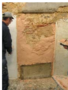
Fig. 57 - Aplicação da argamassa, de baixo para cima
