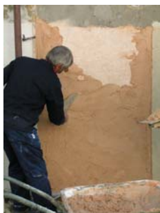
Fig. 52 - Continuação da aplicação da segunda camada do painel 3
