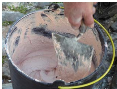
Fig. 8 - Adicionou-se cerca de 0,5l de água
