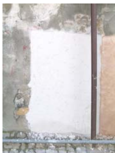
Fig. 39 - Aspecto da argamassa tipo D – painel 4, 3 dias após a sua aplicação
