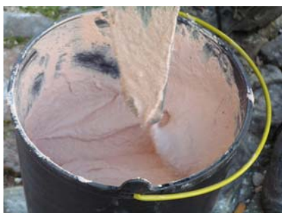
Fig. 9 - Textura final da massa, com consistência adequada para iniciar a aplicação
