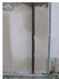
Fig. 16 - Aspecto final do Painel 1
