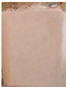
Fig. 43 - Aspecto final do painel 2
