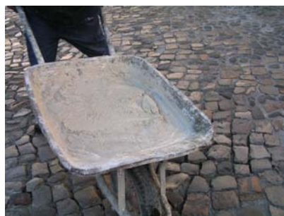
Fig. 32 - Aspecto final da argamassa tipo B, de traço 1:1,5:1,5 (idêntico ao da primeira camada já aplicada)
