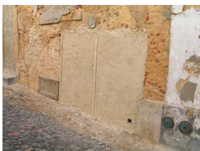
Fig. 53 - Aspecto final dos painéis 1 e 2 – Argamassas tipo A e B, respectivamente
