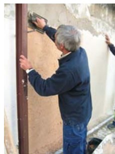
Fig. 10 - Regularização da camada de argamassa com talocha
