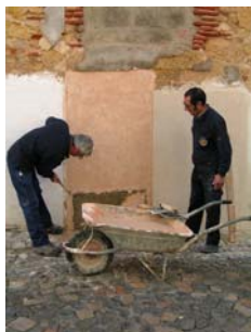
Fig. 29 - Início da aplicação da argamassa, de baixo para cima
