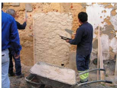
Fig. 47 - Aplicação da primeira camada de argamassa do painel 1 – Edifício 2
