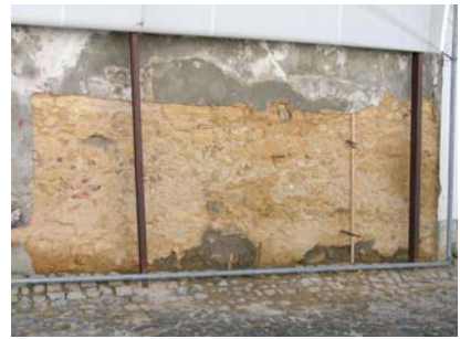
Fig. 2 - Aspecto geral do suporte de alvenaria onde serão aplicados os painéis experimentais
