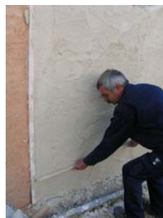
Fig. 14 - Regularização da camada de reboco, com uma ripa de madeira (sentido horizontal)
