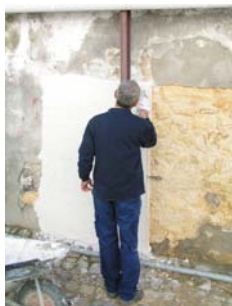
Fig. 31 - Aspecto final do painel 4 – Argamassa tipo D
