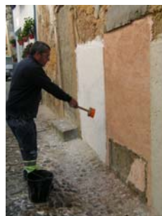
Fig. 36 - Molhagem da argamassa tipo C – painel 3
