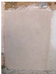
Fig. 43 - Aspecto do painel 2 finalizado – Argamassa tipo B (espessura total aproximada = 2,5 – 3cm)
