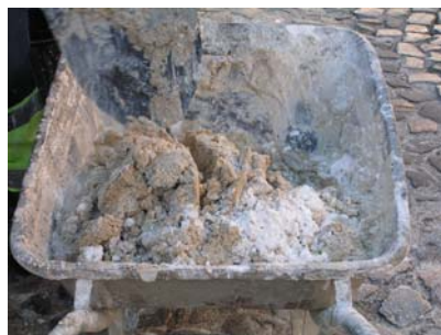
Fig. 30 - Amassadura manual no carrinho de mão
