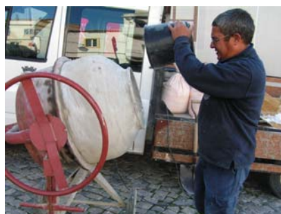
Fig. 29 - Início da execução da argamassa tipo C, de traço 1:0,5:2,5 (metacaulino, cal e areia grossa e fina)
