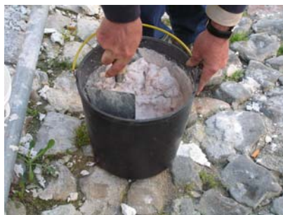
Fig. 6 - Amassadura manual da massa de acabamento
