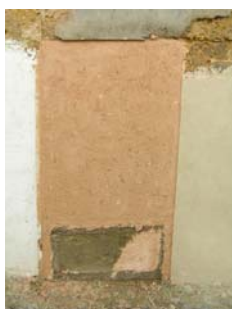
Fig. 62 - Aspecto final da segunda camada de argamassa do painel 3
