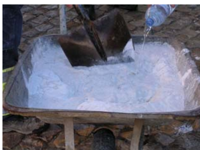
Fig. 19 - Início da amassadura manual, directamente no carrinho de mão
