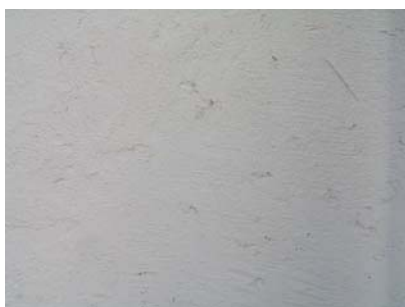
Fig. 25 - Pormenor da textura da argamassa tipo D
