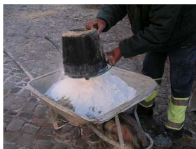
Fig. 2 - Adição de 1,5 baldes de cal
