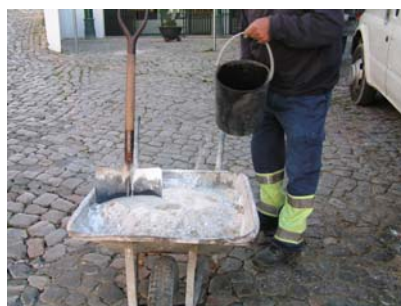
Fig. 4 - Adição de água
