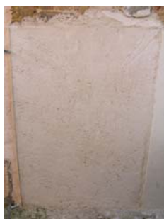
Fig. 31 - Aspecto final da segunda camada de argamassa do painel 2, cerca de 6 semanas após a sua aplicação
