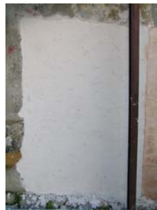
Fig. 6 - Aspecto final da primeira camada de argamassa do painel 4, cerca de 2 meses após a sua aplicação
