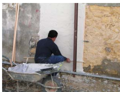
Fig. 24 - Regularização da camada de reboco, com uma ripa de madeira
