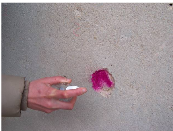
Fig. 16 – Ensaio de carbonatação
