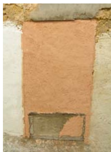
Fig. 62 - Aspecto final da argamassa tipo C
