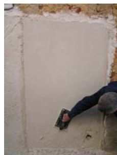
Fig. 28 - Finalização da regularização da terceira camada de argamassa tipo A
