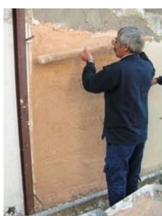
Fig. 7 - Depois de finalizada a aplicação, regularização da camada
