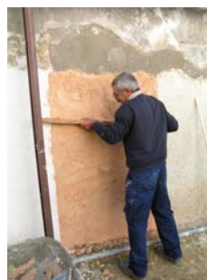
Fig. 35 - Regularização da camada de reboco, com uma ripa de madeira
