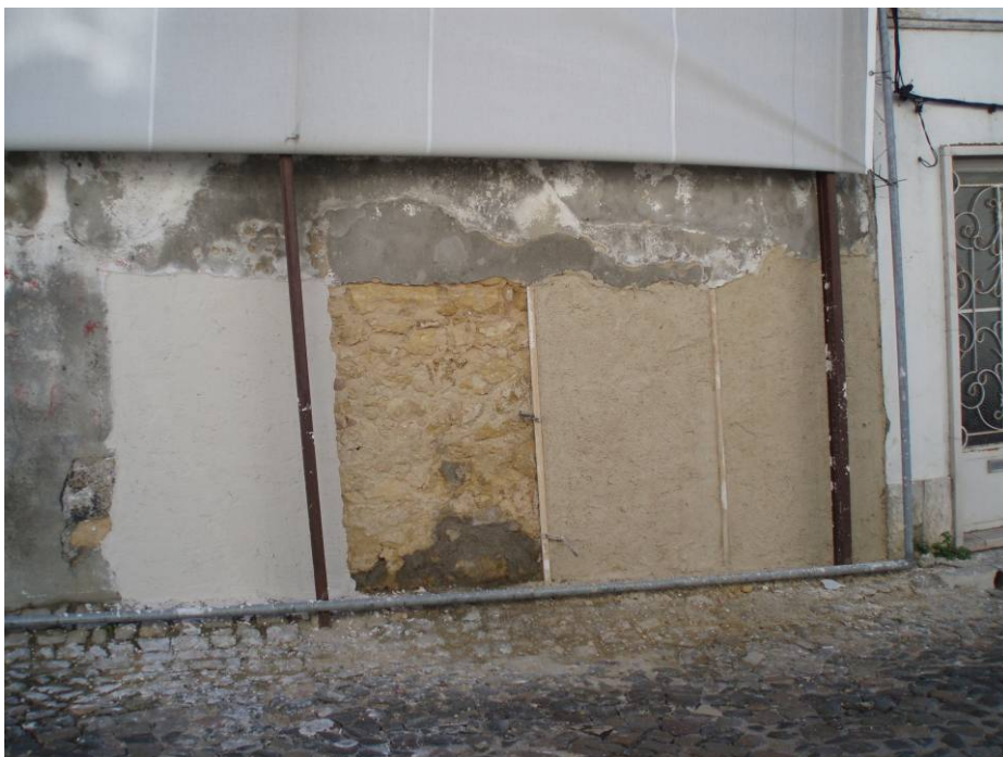
Fig. 1 – Aspecto inicial das primeiras aplicações de painéis do Largo do Mercado
