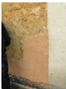
Fig. 34 - Continuação da aplicação da argamassa, de baixo para cima
