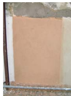
Fig. 18 - Aspecto final do painel 3
