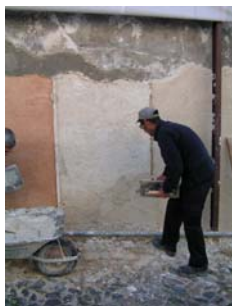
Fig. 9 - Início da aplicação da segunda camada da argamassa tipo B
