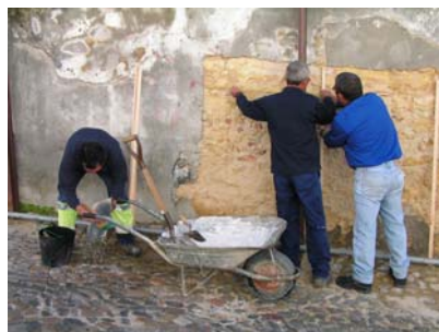
Fig. 22 - Marcação dos limites do painel 4, para aplicação da argamassa tipo D
