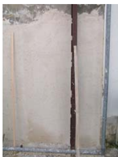
Fig. 5 - Aspecto final da segunda camada de argamassa do painel 1, após 4 dias da sua aplicação
