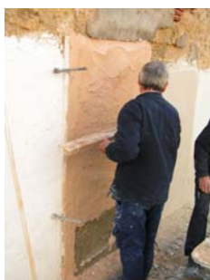
Fig. 35 - Continuação da regularização da camada de argamassa
