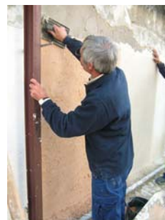
Fig. 10 - Regularização da camada de argamassa com talocha
