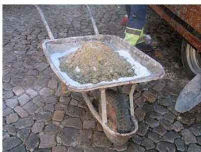
Fig. 25 - Materiais antes da amassadura manual
