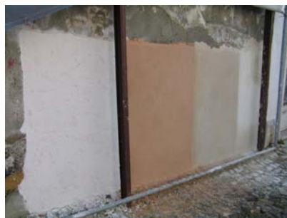
Fig. 20 - Vista geral dos 4 painéis finalizados
