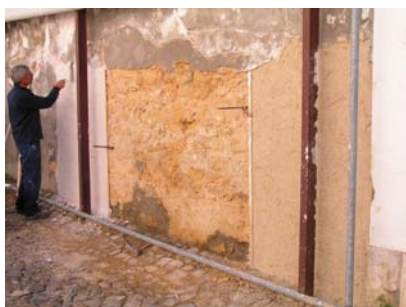
Fig. 27 - Retoques finais para eliminação de material excedente na camada
