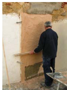
Fig. 34 - Após a aplicação, regularização da camada de argamassa com régua da madeira
