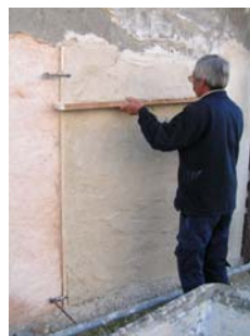
Fig. 14 - Após a aplicação, regularização da camada de argamassa com régua da madeira
