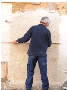
Fig. 37 - Após a aplicação, regularização da camada de argamassa com régua da madeira
