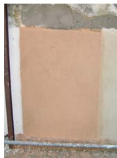
Fig. 18 - Aspecto final do painel 3
