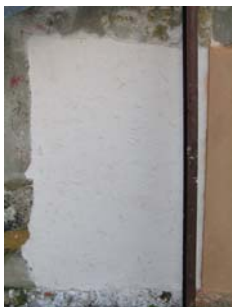
Fig. 19 - Aspecto final do painel 4
