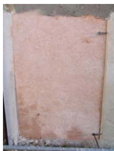
Fig. 9 - Aspecto final da primeira camada de argamassa do painel 3, cerca de 2 meses após a sua aplicação
