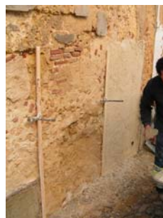
Fig. 50 - Aspecto do suporte em alvenaria antiga do painel 2 – Argamassa tipo B
