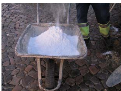
Fig. 23 - Junção de um balde de cal
