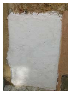
Fig. 63 - Aspecto final da primeira camada de argamassa do painel 4, cerca de 6 semanas após a sua aplicação
