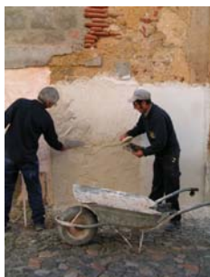
Fig. 35 - Continuação da aplicação da camada de argamassa
