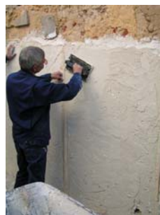
Fig. 26 - Regularização da terceira camada de argamassa tipo A com talocha – painel 1 (de baixo para cima)
