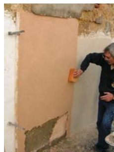
Fig. 40 - Passagem com esponja humedecida para alisar a camada de argamassa
