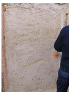
Fig. 33 - Molhagem do suporte para melhorar a aderência da camada a aplicar em seguida
