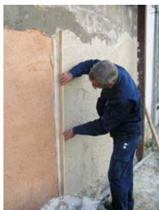
Fig. 13 - Regularização da camada de reboco, com uma ripa de madeira (sentido vertical)
