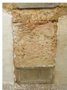
Fig. 50 - Aspecto do suporte de alvenaria antiga destinado à aplicação da argamassa tipo C
