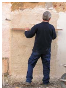
Fig. 38 - Regularização da camada de argamassa com régua da madeira (continuação)
