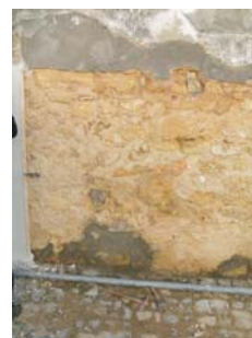
Fig. 30 - Aspecto do suporte em alvenaria antiga do painel 3 – Argamassa tipo C
