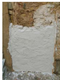
Fig. 24 - Continuação da aplicação da argamassa, de baixo para cima
