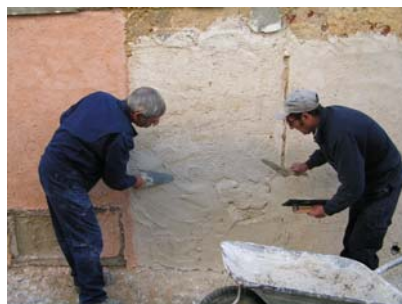
Fig.38 - Aplicação da segunda camada da argamassa do painel B
