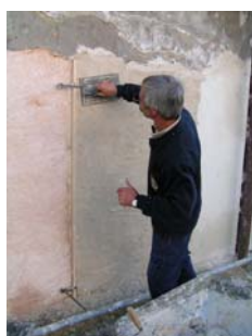
Fig. 17 - Regularização da camada de argamassa com talocha
