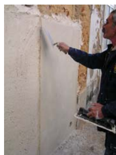
Fig. 30 - Retoques finais com colher de pedreiro
