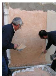
Fig. 6 - Continuação da aplicação da camada de argamassa com régua de madeira
