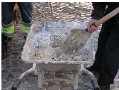
Fig. 29 - Início da execução da segunda camada da argamassa tipo B – cal e areia
