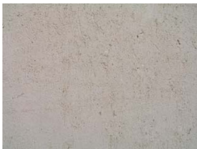
Fig. 27 - Pormenor da textura da argamassa tipo B
