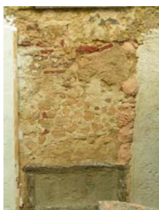
Fig. 55 - Suporte de alvenaria antiga destinado à aplicação da argamassa tipo C
