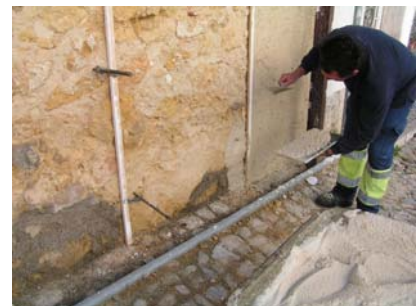
Fig. 36 - Início da aplicação da argamassa tipo B, de baixo para cima
