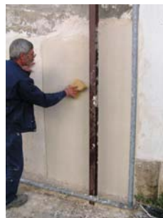
Fig. 16 - Passagem com esponja humedecida para alisar a camada de argamassa
