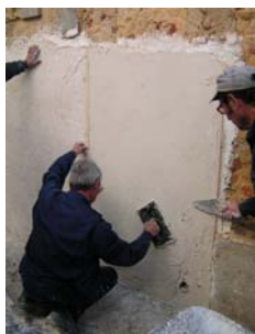
Fig. 27 - Continuação da regularização da terceira camada de argamassa tipo A
