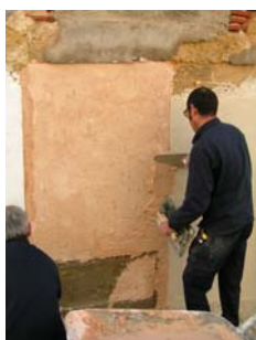
Fig. 31 - Continuação da aplicação da camada final de argamassa
