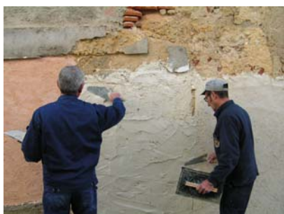
Fig. 39 - Finalização da aplicação da segunda camada da argamassa do painel B
