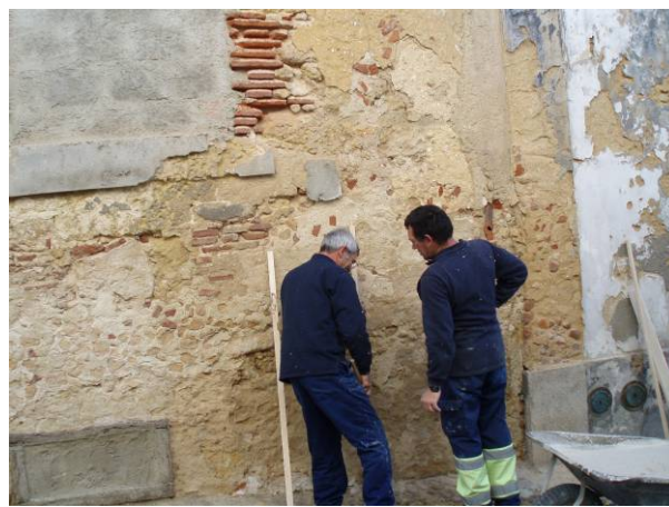
Fig. 5 – Aspecto da parede do edifício da Rua Contra-Almirante Jaime Afreixo antes do início da aplicação dos painéis
