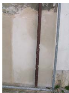
Fig. 57 - Aspecto final da terceira camada de argamassa do painel 1, cerca de 6 semanas após a sua aplicação
