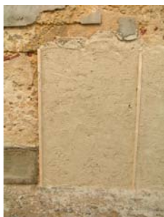
Fig. 51 - Aspecto final do painel 2 – Argamassa tipo B, já regularizado
