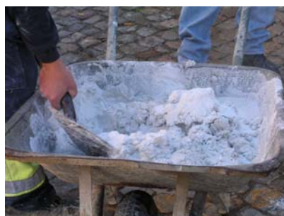
Fig. 20 - Amassadura para boa junção do pó com a água
