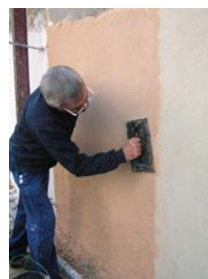
Fig. 12 - Continuação dos trabalhos, pressionando com a talocha com movimentos circulares
