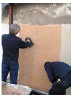
Fig. 11 - Continuação dos trabalhos, pressionando com a talocha com movimentos circulares
