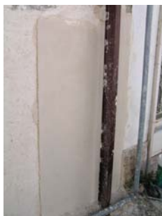
Fig. 17 - Aspecto do painel 1 finalizado – Argamassa tipo A (espessura total aproximada = 2,5 – 3cm)
