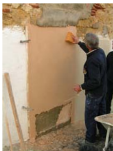
Fig. 41 - Continuação do alisamento final da camada, com esponja humedecida
