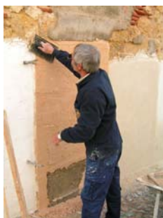
Fig. 37 - Início do “aperto” da camada final de argamassa
