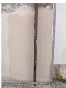
Fig. 21 - Aspecto do painel 1 finalizado – Argamassa tipo A
