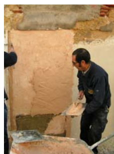
Fig. 32 - Continuação dos trabalhos
