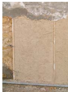
Fig. 42 - Aspecto final do painel 2 – Argamassa tipo B, já regularizado
