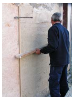
Fig. 15 - Regularização da camada de argamassa com régua da madeira (continuação)
