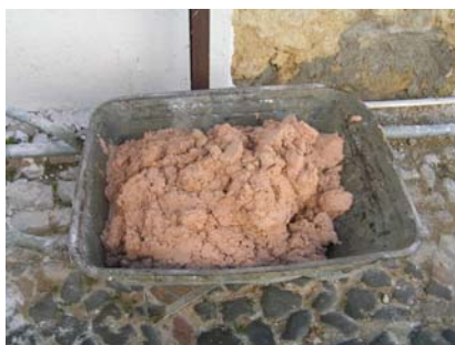
Fig. 32 - Um carrinho de mão – quantidade suficiente para uma camada de revestimento
