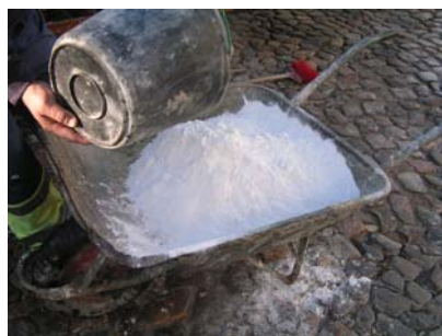
Fig. 45 - Junção de um balde de cal
