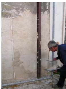
Fig. 44 - Início da aplicação da segunda camada de revestimento, de traço 1:2:9, da argamassa tipo A
