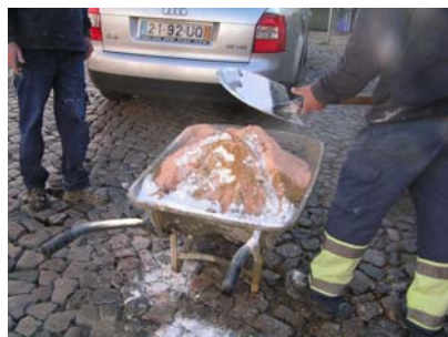
Fig. 47 - Início da amassadura manual
