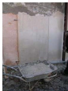
Fig. 10 - Início da aplicação da terceira e última camada da argamassa tipo B do painel 2
