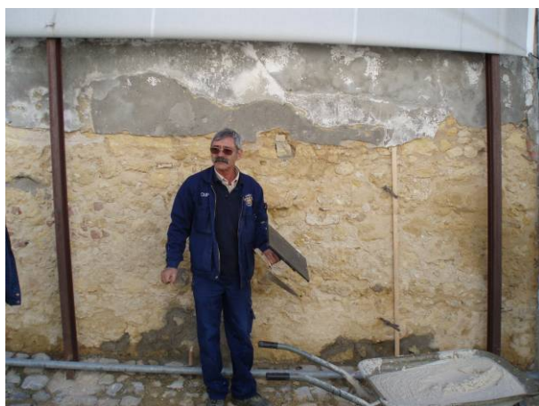
Fig. 4 – Aspecto da parede do edifício do Largo do Mercado antes do início da aplicação dos painéis
