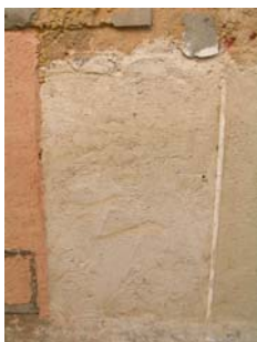
Fig. 63 - Aspecto final da argamassa tipo B
