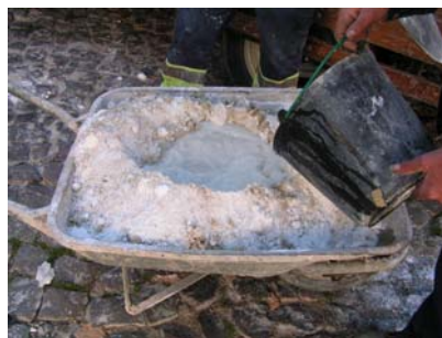
Fig. 2 - Adição de água à amassadura
