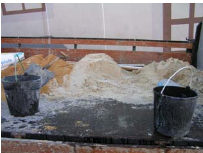
Fig. 11 - Três tipos de areia utilizados na execução das camadas de reboco
