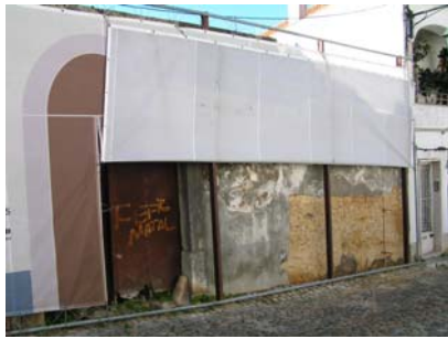
Fig. 1 - Preparação da área da fachada onde serão aplicados os painéis experimentais
