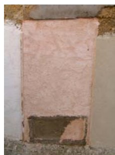
Fig. 32 - Aspecto final da primeira camada de argamassa do painel 3, cerca de 2 meses após a sua aplicação
