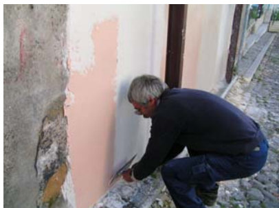
Fig. 11 - Continuação da aplicação da camada de argamassa, com uma espessura aproximada de 2 mm
