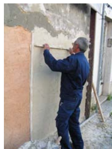
Fig. 16 - Continuação da regularização da camada de reboco – eliminação de argamassa excedente
