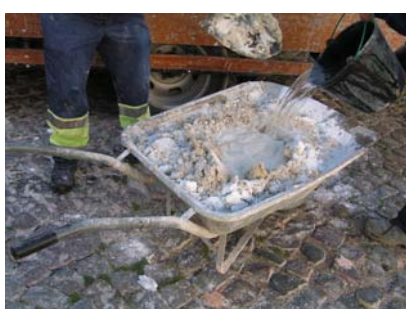
Fig. 3 - Adição de mais água à amassadura
