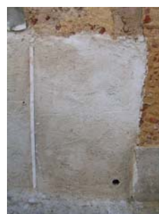
Fig. 16 - Aspecto visual da primeira camada de revestimento da argamassa tipo A
