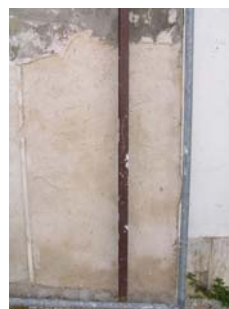
Fig. 37 - Aspecto final da argamassa tipo A
