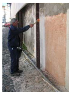
Fig. 20 - Molhagem da argamassa tipo C – painel 3
