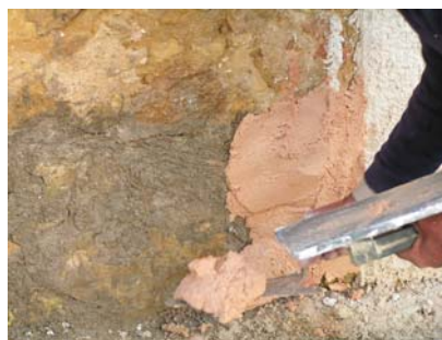
Fig. 33 - Início da aplicação da argamassa tipo C
