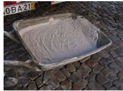
Fig. 34 - Aspecto final da argamassa tipo B, destinada à primeira camada de revestimento do painel 2
