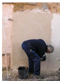
Fig. 40 - Continuação dos trabalhos, pressionando com a talocha com movimentos circulares
