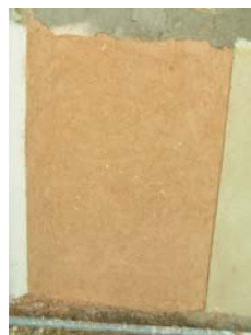
Fig. 59 - Aspecto final da segunda camada de argamassa do painel 3
