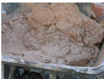
Fig. 3 - Continuação da amassadura manual da argamassa
