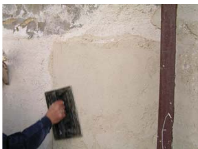
Fig. 9 - Continuação dos trabalhos, pressionando com a talocha com movimentos circulares
