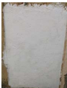
Fig. 33 - Aspecto final da primeira camada de argamassa do painel 4, cerca de 6 semanas após a sua aplicação
