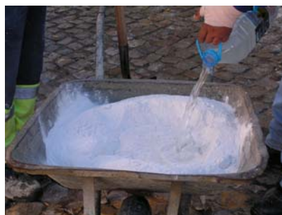
Fig. 18 - Junção de 6-6,5l de água ao conteúdo de um saco de 30 kg
