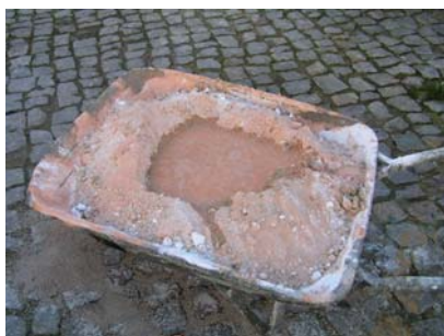
Fig. 48 - Junção de água
