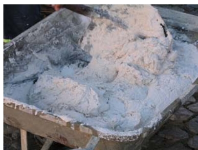
Fig. 14 - Amassadura manual da argamassa tipo D
