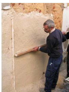
Fig. 53 - Regularização da camada de revestimento após aplicação da segunda camada de revestimento, de traço 1:2:9, da argamassa tipo A, com uma ripa de madeira
