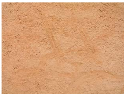
Fig. 49 - Aspecto da textura da argamassa tipo C
