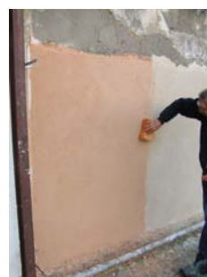
Fig. 14 - Passagem com esponja humedecida para alisar a camada de argamassa
