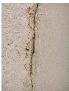
Fig. 29 - Terceira camada do painel 1 - 4-5 mm de espessura
