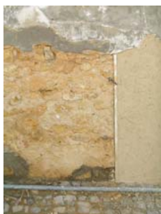
Fig. 29 - Aspecto do suporte em alvenaria antiga do painel 2 – Argamassa tipo B
