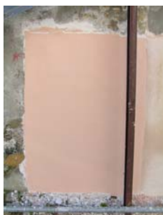
Fig. 17 - Aspecto do painel 4, finalizado
