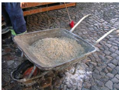
Fig. 44 - Início da execução da 2ª camada da argamassa de metacaulino tipo C, de traço 1:0,5:3,5
