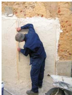
Fig. 23 - Regularização da 3ª camada de argamassa do painel 1, após aplicada
