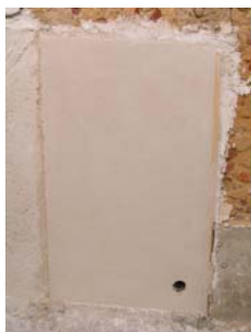
Fig. 35 - Aspecto da argamassa tipo A – painel 1, finalizada a sua aplicação
