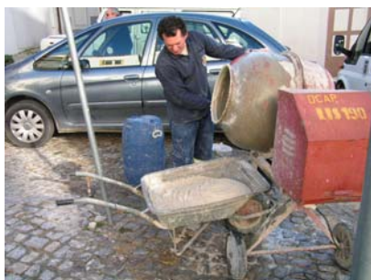
Fig. 49 - Aspecto final da argamassa do painel 2, de traço 1:1,5:1,5
