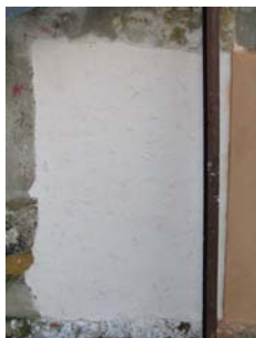
Fig. 19 - Aspecto final do painel 4
