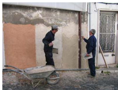
Fig. 45 - Aplicação da argamassa, de baixo para cima
