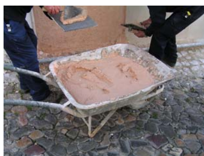
Fig. 4 - Início da aplicação da terceira e última camada da argamassa tipo C
