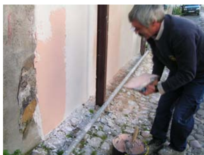
Fig. 10 - Início da aplicação da camada da massa, com uma talocha lisa de aço
