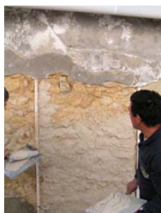
Fig. 39 - Continuação da aplicação da primeira camada do painel 2
