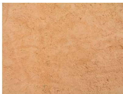
Fig. 26 - Pormenor da textura da argamassa tipo C
