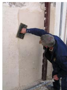
Fig. 12 - Regularização final com talocha
