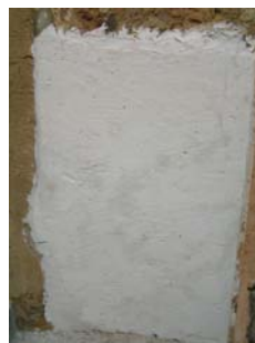
Fig. 32 - Aspecto da argamassa tipo D – painel 4, 3 dias após a sua aplicação
