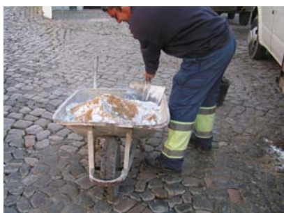
Fig. 3 - Amassadura manual da argamassa
