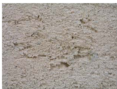
Fig. 34 - Aspecto da argamassa tipo A – Painel 1
