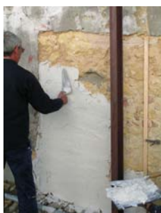
Fig. 23 - Aplicação da primeira camada de reboco
