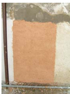
Fig. 38 - Aspecto final da argamassa tipo C
