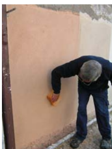
Fig. 15 - Aspecto do painel 3 finalizado – Argamassa tipo C (espessura total aproximada 2,5 – 3 cm)
