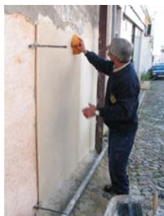
Fig. 19 - Passagem com esponja humedecida para alisar a camada de argamassa
