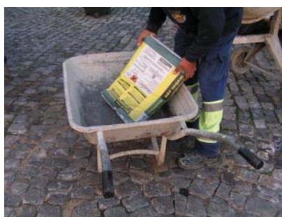
Fig. 2 - Saco de 30 kg de argamassa tipo D (pré-doseada), marca Weber
