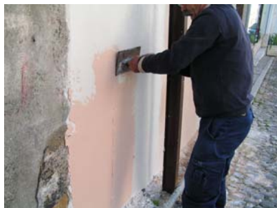
Fig. 12 - Continuação da aplicação da camada de argamassa, de baixo para cima
