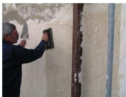
Fig. 8 - Regularização da camada de argamassa com talocha
