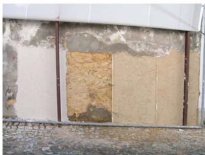
Fig. 41 - Aspecto final dos três painéis executados – 1, 2 e 4
