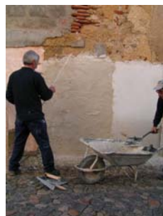
Fig. 36 - Conclusão da aplicação da camada de argamassa
