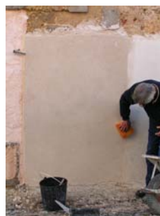
Fig. 42 - Continuação do humedecimento da camada de argamassa aplicada
