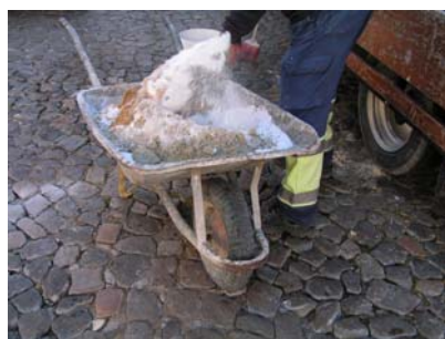
Fig. 26 - Amassadura manual da argamassa
