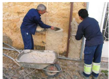
Fig. 8 - Continuação dos trabalhos de aplicação da primeira camada
