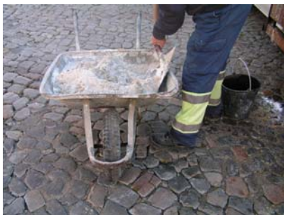
Fig. 5 - Continuação da amassadura manual da argamassa
