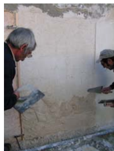
Fig. 12 - Continuação da aplicação da camada de argamassa
