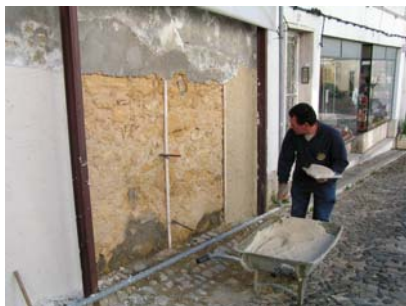
Fig. 35 - Início da aplicação do reboco de traço 1:1,5:1,5 (cal, areia grossa e areia fina)
