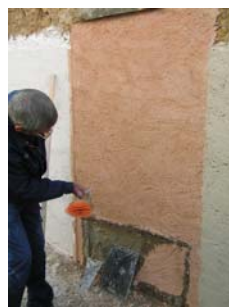
Fig.42 - Molhagem da camada de argamassa tipo C – Painel 3
