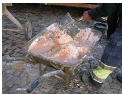
Fig. 54 - Início da execução da argamassa tipo C, de traço 1:0,5:3,5 (metacaulino, cal e areia grossa e fina)
