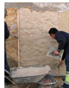
Fig. 40 - Aspecto final do painel 2 – Argamassa tipo B, ainda não regularizado
