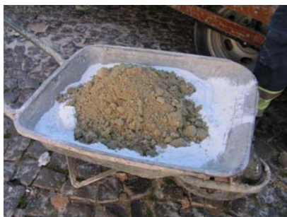
Fig. 1 - Início da execução da 3ª camada da argamassa tipo A, de traço 1:3:12 – painel 1
