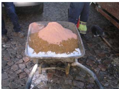
Fig. 46 - Junção de 1,15 baldes de areia grossa e de meio balde de metacaulino
