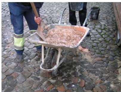
Fig. 1 - Início da execução da 3ª camada da argamassa de cal e metacaulino, de traço 1:0,5:3,5 – Painel 3
