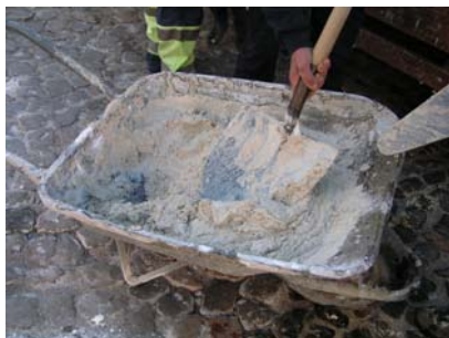
Fig. 5 - Continuação da amassadura
