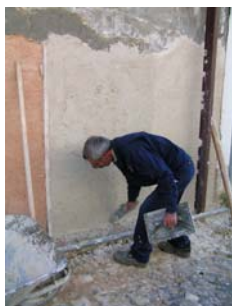
Fig. 15 - Eliminação de argamassa excedente com colher de pedreiro
