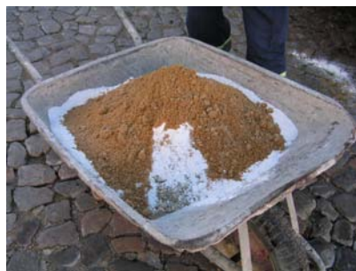
Fig. 2 - Adição de um balde cal, um balde e meio de cada tipo de areia
