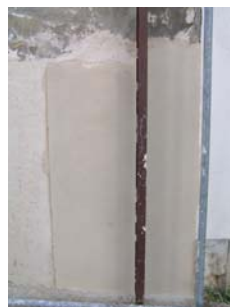
Fig. 42 - Aspecto do painel 1 finalizado – Argamassa tipo A, 1 hora após a sua aplicação
