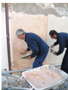
Fig. 3 - Continuação da amassadura manual da argamassa
