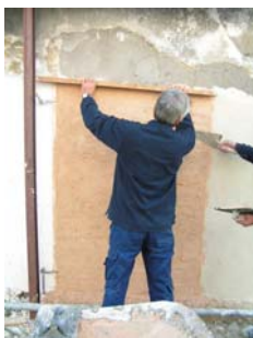
Fig. 9 - Continuação da regularização da camada de argamassa com régua de madeira
