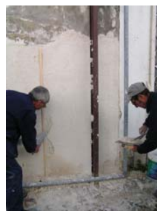
Fig. 6 - Início da aplicação da terceira camada de argamassa tipo A – painel 1 (de baixo para cima)
