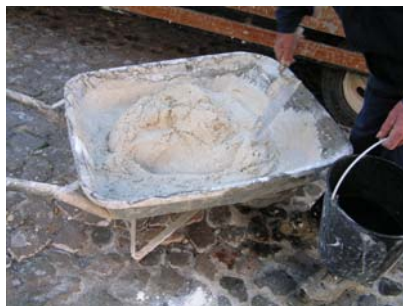
Fig. 6 - Aspecto final da argamassa depois de amassada
