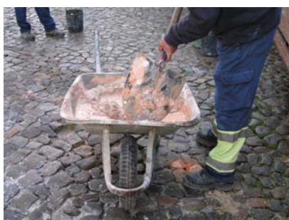
Fig. 27 - Amassadura manual da argamassa
