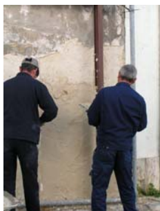
Fig. 46 - Continuação da aplicação da argamassa
