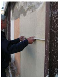
Fig. 17 - Continuação da regularização da camada de reboco – eliminação de argamassa excedente
