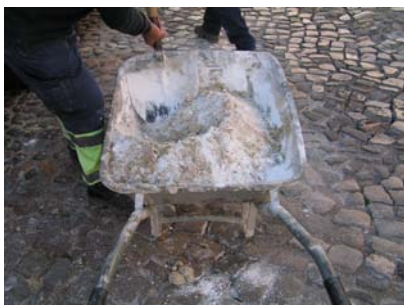
Fig. 29 - Início da execução da segunda camada da argamassa tipo B – cal e areia
