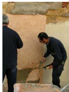
Fig. 30 - Continuação da aplicação da camada final de argamassa
