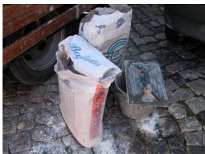
Fig. 15 - Saco de cal aérea hidratada em pó, saco de cimento II 32,5 branco, talocha e balde de 10 litros
