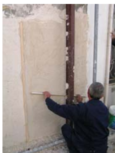
Fig. 7 - Após a aplicação, regularização da camada de argamassa com régua da
