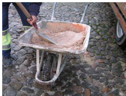
Fig. 2 - Amassadura manual da argamassa
