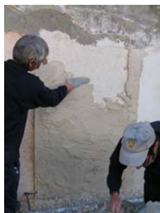
Fig. 13 - Continuação da aplicação da camada de argamassa
