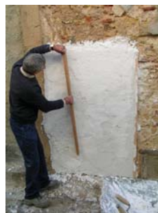
Fig. 26 - Regularização da camada de reboco, com uma ripa de madeira
