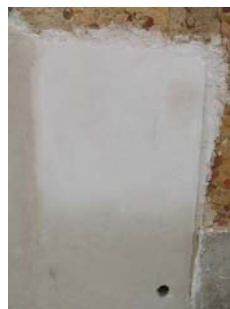
Fig. 42 - Aspecto final do painel 1
