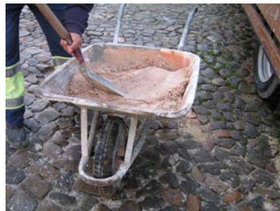
Fig. 2 - Amassadura manual da argamassa
