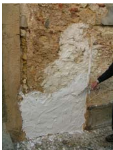
Fig. 23 - Continuação da aplicação da argamassa, de baixo para cima
