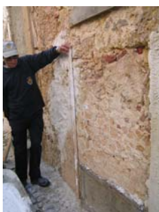
Fig. 19 - Colocação de régua para início da aplicação da primeira camada do painel 4 – Argamassa tipo D
