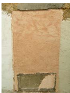
Fig. 33 - Aspecto da argamassa tipo C – painel 3, 3 dias após a sua aplicação
