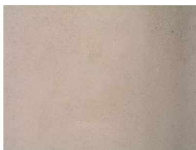
Fig. 22 - Pormenor da textura da argamassa tipo A - painel 1
