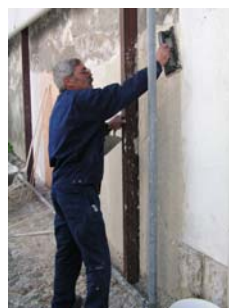
Fig. 14 - Regularização final com talocha
