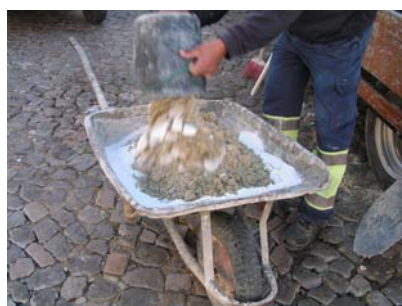
Fig. 24 - Junção de um balde e meio de areia com goma
