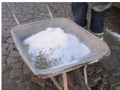
Fig. 1 - Início da execução da 3ª camada da argamassa de cal e areia tipo B, de traço 1:1,5:1,5 – Painel 2
