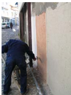
Fig. 19 - Continuação da molhagem da argamassa tipo C
