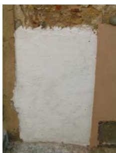
Fig. 45 - Aspecto final do painel 4
