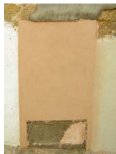
Fig. 44 - Aspecto final do painel 3
