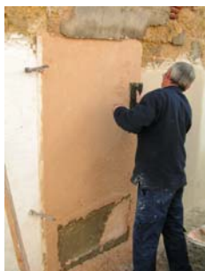
Fig. 39 - Continuação da regularização da camada de argamassa com talocha
