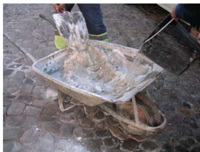
Fig. 4 - Adição de água à amassadura
