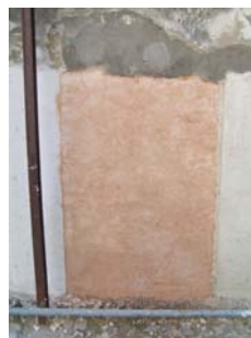
Fig. 40 - Aspecto da argamassa tipo C– painel 3, 3 dias após a sua aplicação
