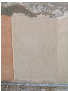
Fig. 21 - Aspecto final do painel 2 - Argamassa tipo B
