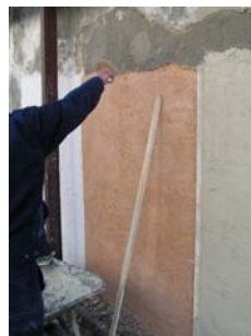
Fig. 18 - Molhagem da argamassa tipo C (recomendável para evitar fissuração)
