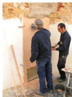
Fig. 38 - Regularização da camada de argamassa com talocha, com movimentos circulares
