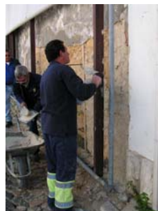
Fig. 10 - Primeira camada do painel 1 quase concluída
