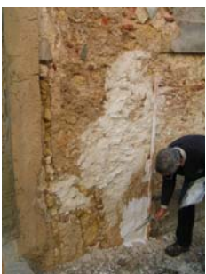
Fig. 21 - Início da aplicação da primeira camada, sobre o suporte previamente regularizado
