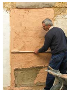
Fig. 58 - Regularização da camada de reboco, com uma ripa de madeira
