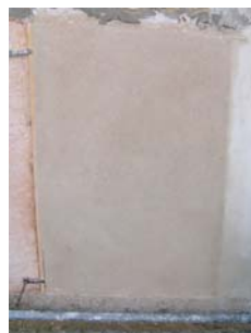
Fig. 20 - Aspecto do painel 2 finalizado – Argamassa tipo B (espessura total aproximada = 2,5 – 3cm)
