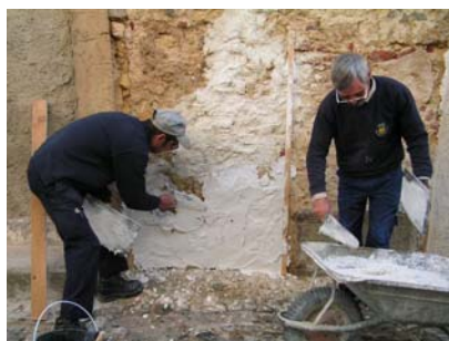
Fig. 22 - Continuação da aplicação da argamassa, de baixo para cima
