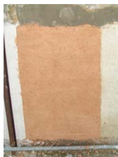
Fig. 36 - Aspecto final da argamassa tipo C
