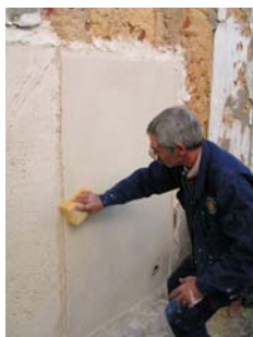
Fig. 31 - Passagem com esponja humedecida para alisar a camada de argamassa
