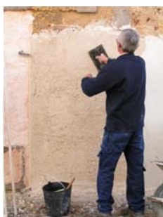
Fig. 39 - Regularização da camada de argamassa com talocha
