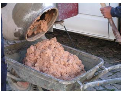
Fig. 30 - Preparação da argamassa tipo C para transporte até ao local de aplicação
