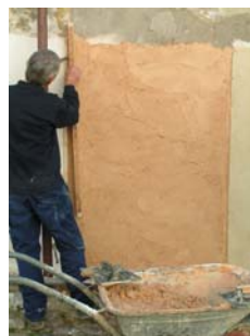
Fig. 53 - Conclusão da aplicação da segunda camada do painel 3
