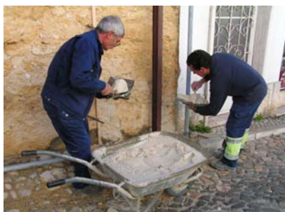
Fig. 7 - Início da aplicação da primeira camada de argamassa, de traço 1:1:6
