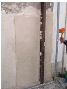
Fig. 11 - Depois de regularizada a camada aplicada, molhagem para secagem moderada
