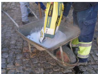
Fig. 17 - Início da execução da argamassa tipo D, pré-doseada, a aplicar no painel 4
