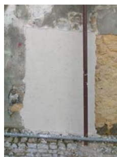
Fig. 44 - Aspecto final do painel 4, após cerca de 20 minutos de secagem
