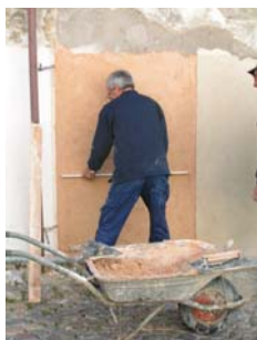
Fig. 54 - Após a aplicação da camada, regularização com régua de madeira
