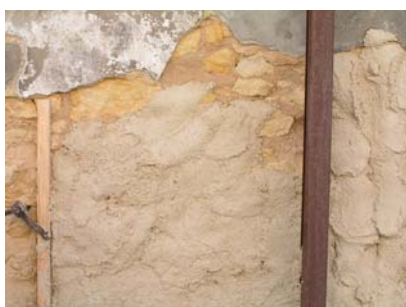
Fig. 11 - Pormenor do aspecto visual do reboco
