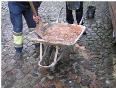
Fig. 1 - Início da execução da 3ª camada da argamassa de cal e metacaulino, de traço 1:0,5:3,5 – Painei 3
