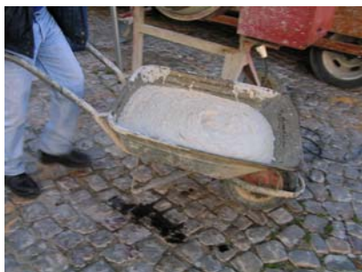
Fig. 5 - Argamassa tipo A – aspecto final
