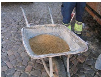
Fig. 21 - Início da execução da 3ª camada da argamassa de cal e areia tipo B, de traço 1:1,5:1,5 – Painel 2
