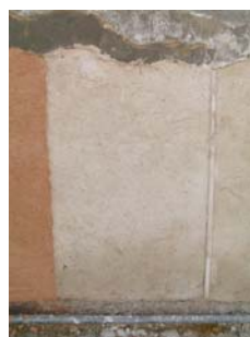
Fig. 39 - Aspecto final da argamassa tipo B
