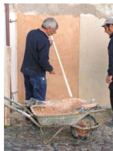
Fig. 55 - Argamassa excedente retirada para o carrinho de mão
