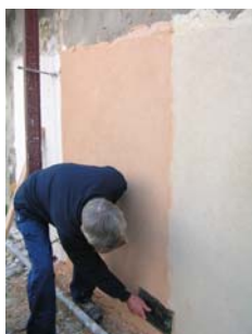
Fig. 13 - Continuação dos trabalhos, pressionando com a talocha com movimentos circulares
