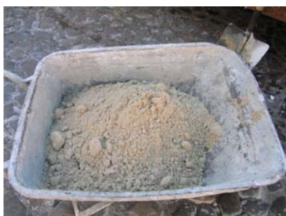
Fig. 1 - Início da execução da segunda camada da argamassa tipo B – cal, areia grossa e areia fina rio
