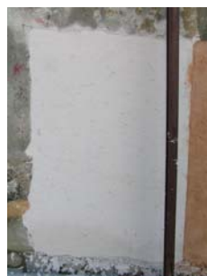
Fig. 24 - Aspecto final do painel 4 - Argamassa tipo D
