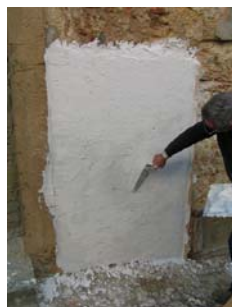
Fig. 27 - Aspecto final do painel 4 – Argamassa tipo D
