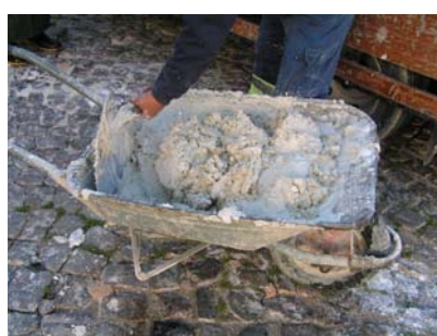
Fig. 4 - Amassadura manual da argamassa
