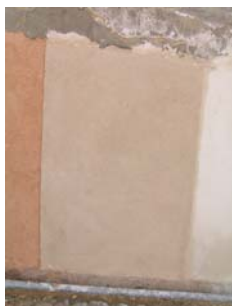
Fig. 58 - Aspecto final da segunda camada de argamassa do painel 2, cerca de 6 semanas após a sua aplicação
