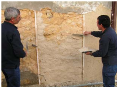
Fig. 37 - Aspecto visual do painel 2, quase concluído
